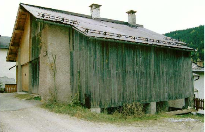
NOTE SUL RILIEVO
