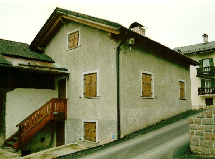
NOTE SUL RILIEVO
